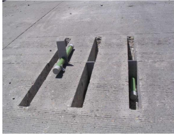
Figura 405-2. Colocación de dovelas
