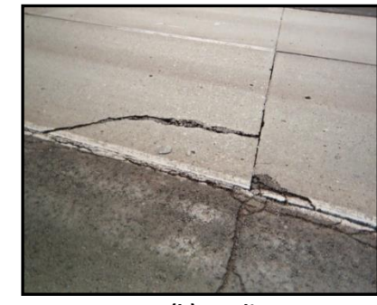
Figura 2.43 Esquema Grieta de Esquina- Pavimento Rígido
