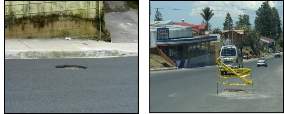
Figura 2.39 Caso especial, Alcantarillas Desniveladas
