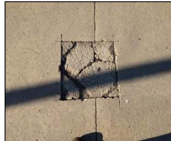
Figura 2.69 Imágenes del nivel de severidad alta asociado a Baches menores a 0,5 m 2
