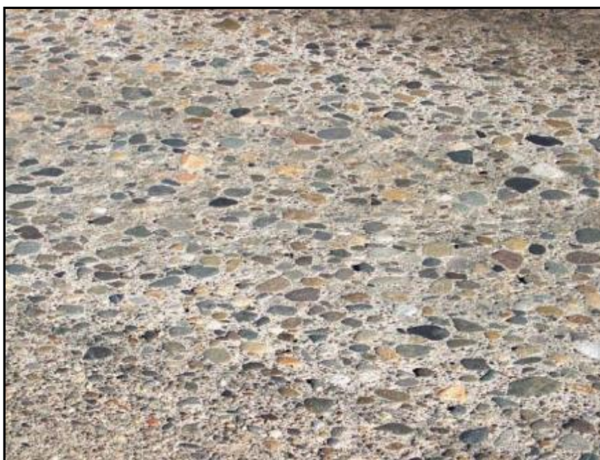
Figura 4.55 Imagen asociada a Pulimiento de Agregados
