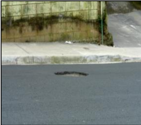
Figura 4.39 Caso especial, Alcantarillas Desniveladas
