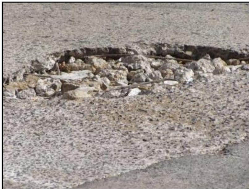
Figura 4.72 Caso Especial, Huecos en Pavimento Rígido.
