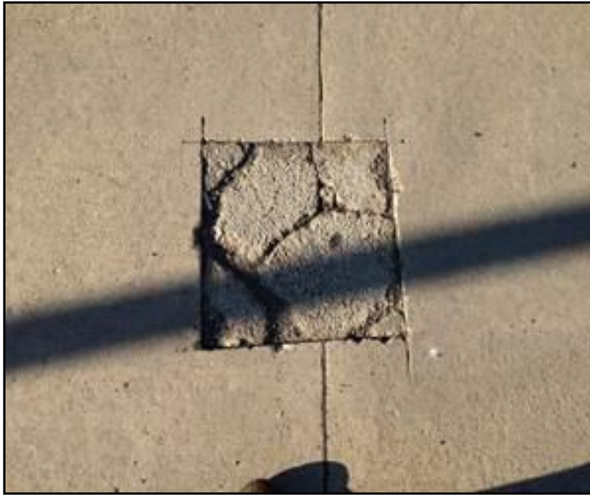
Figura 4.70 Imágenes del nivel de severidad alta asociado a Baches menores a 0,5 \text{ m}^2
