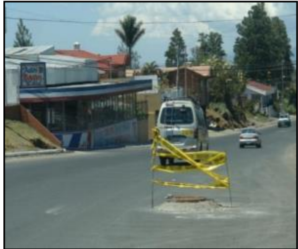
Figura 4.39 Caso especial, Alcantarillas Desniveladas
